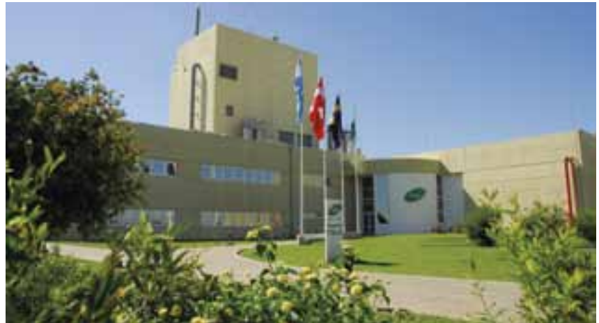
Med en produktionskapacitet på 25.000 ton vallepulver bidrager Arla og SanCor's jointventureselskab til den argentinske mejerivækst.
